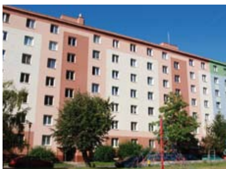
Nový vzhľad paneláka po zmene presvetlenia schodišť
