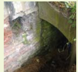
Vstup do bunkra z prvej svetovej vojny pri benzínovej pumpe oproti Mladej garde
