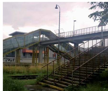
Pripravujeme dokumentáciu na rekonštrukciu lávky pri stanici Predmestie
