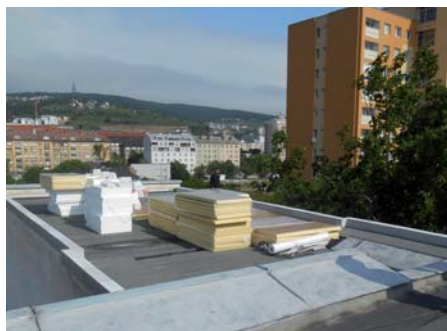
Strecha Gymnázia na Českej bude po rekonštrukcii aj zateplená
