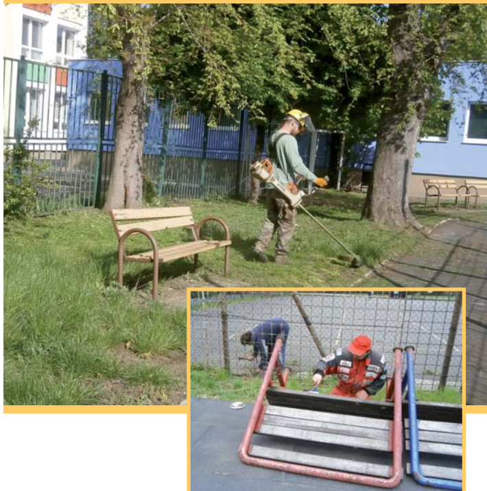
Úprava športovísk v Školak klube
