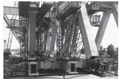
Z montáže Prístavného mosta, konštrukčne navrhnutého ako most diaľnično-železničný
