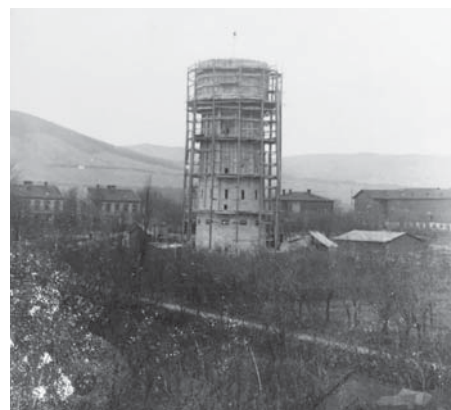
Časť Dynamitky s východnou vodnou vežou v 30. rokoch 20. storočia a výstavba veže na začiatku storočia, archív V. Obuchovej
