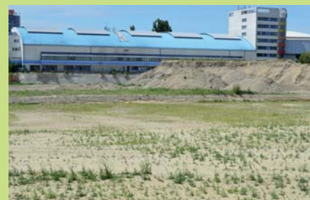
Stavenisko v jame po bývalom futbalovom štadióne zostalo nateraz opustené
