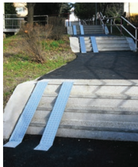
Bezpečnejšie schodisko na Višňovej ulici
