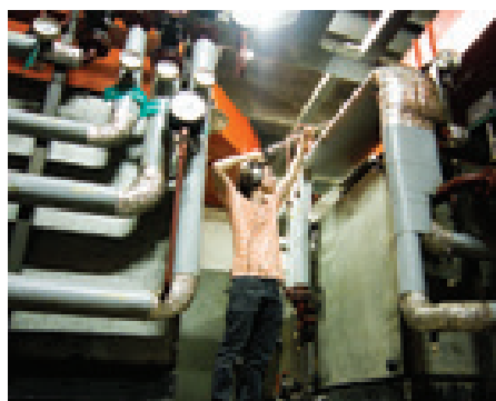
Jonáš Gruska nahráva zvuky v strojnici vzduchotechniky Tržnice
