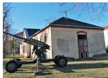
Budova, v ktorej boli stajne
