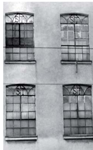
Pôvodné okná označené ST (Stollwerck) boli na uličnej fasáde fabriky len do 80. rokov 20. storočia. Dnes by ich pamiatkari iste nedovolili tak ľahko odstrániť. (Snímka z dokumentácie MUOP v Bratislave)
