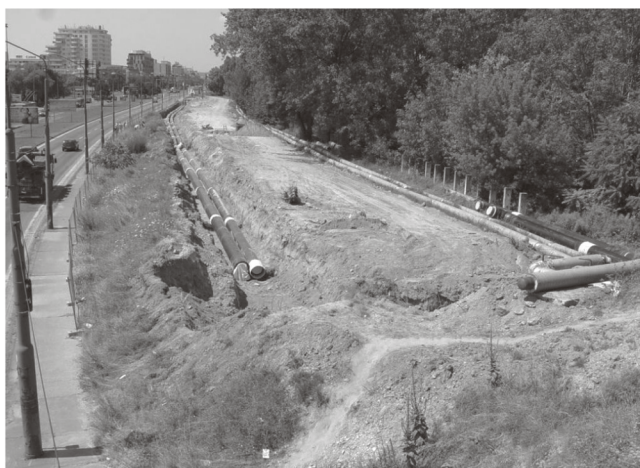
Južná vetva – stavenisko
