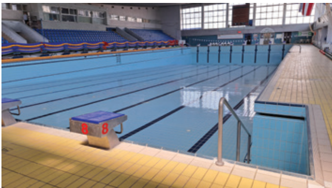
Interiér plavárne tesne pred spustením rekonštrukcie. Takto si ho budú pamätníci pamätať už navždy.
