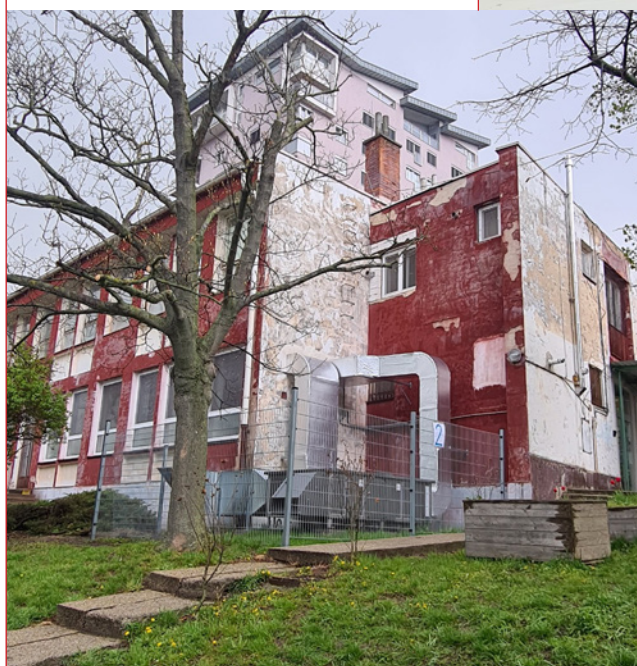
Rekonštrukcia tohto školského pavilónu (vľavo) už bola naozaj nevyhnutná. Výsledok stojí za to.
