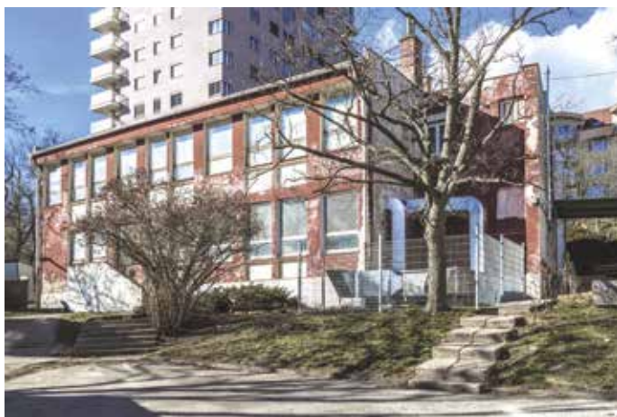
Budova školskej jedálne na ZŠ Cádova, kde je plánovaná rekonštrukcia a nadstavba
